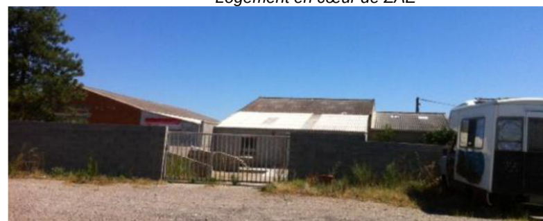
Bâtiment en friche
