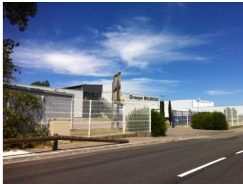
Belle installation du groupe Beuron en fond de zone
